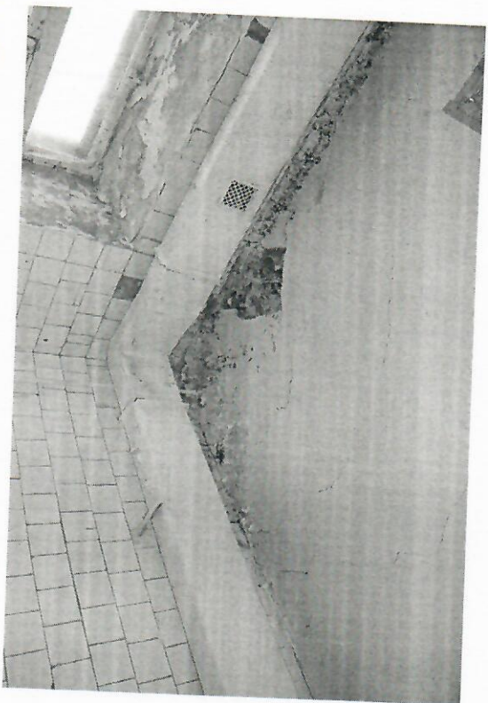
Фото 10. Шелушение красочного слоя на стенах.
