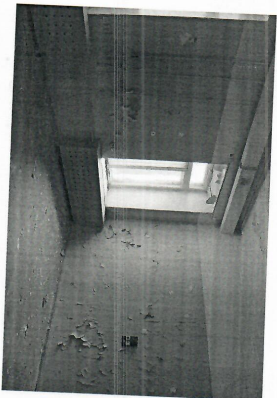
Фото 10. Шелушение красочного слоя на стенах.
