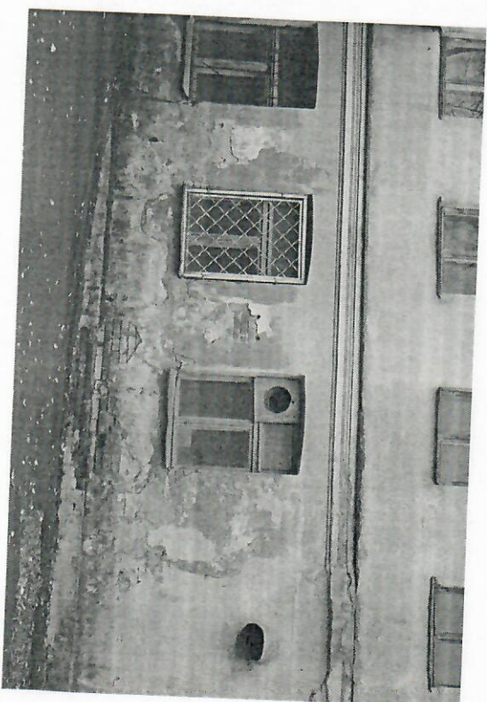
Фото 4. Состояние стен и карнизной части.
