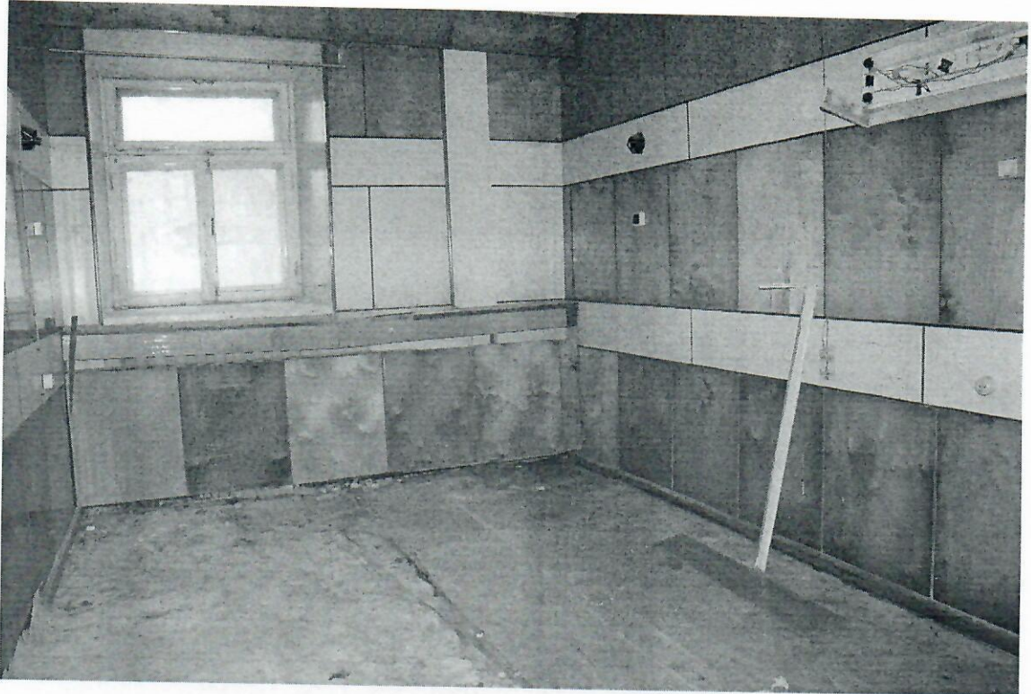
Фото 18. Помещение первого этажа.
