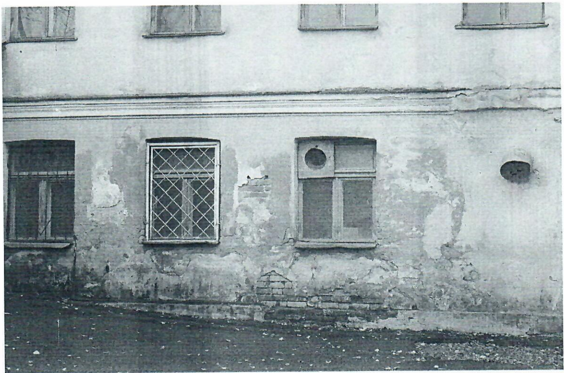
Фото 7. Состояние стен.
