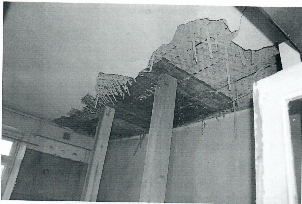
Фото 32. Установленные подпорки под перекрытие на первом этаже.
