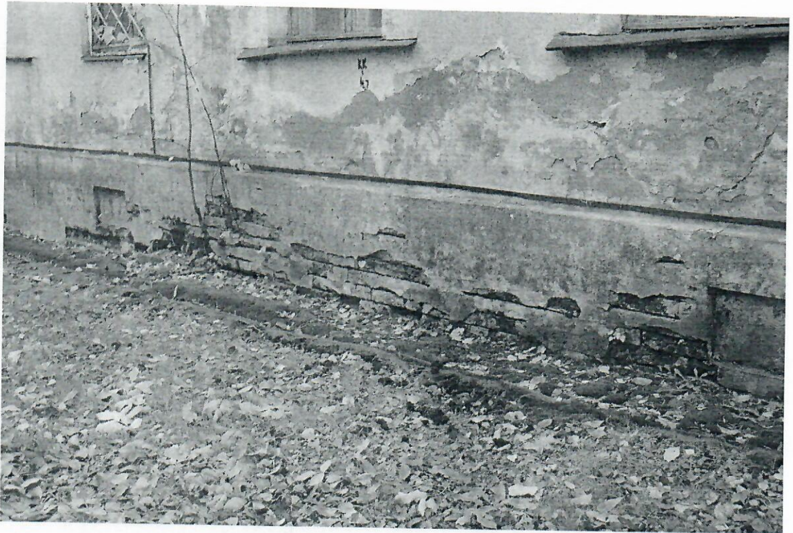
Фото 4. Состояние цокольной части.
