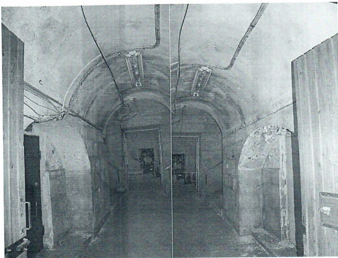
Фото 15, 16. Помещение первого этажа.
