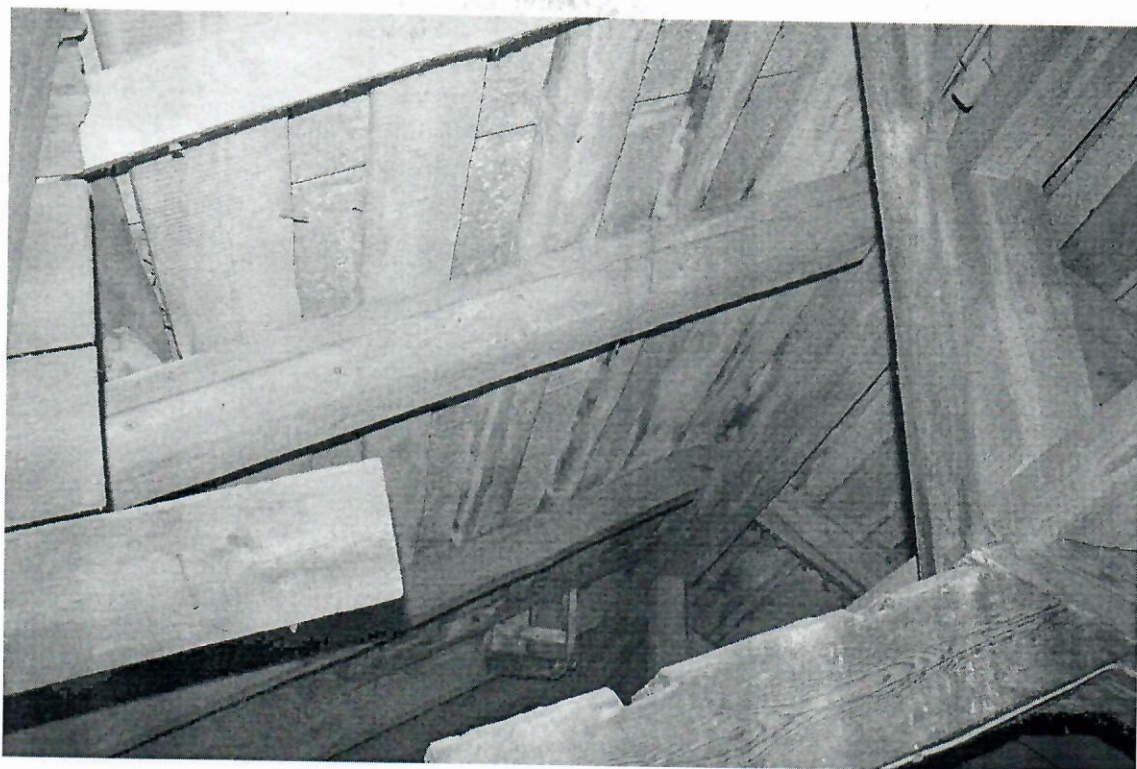
Фото 36. Состояние стропильных конструкций.
