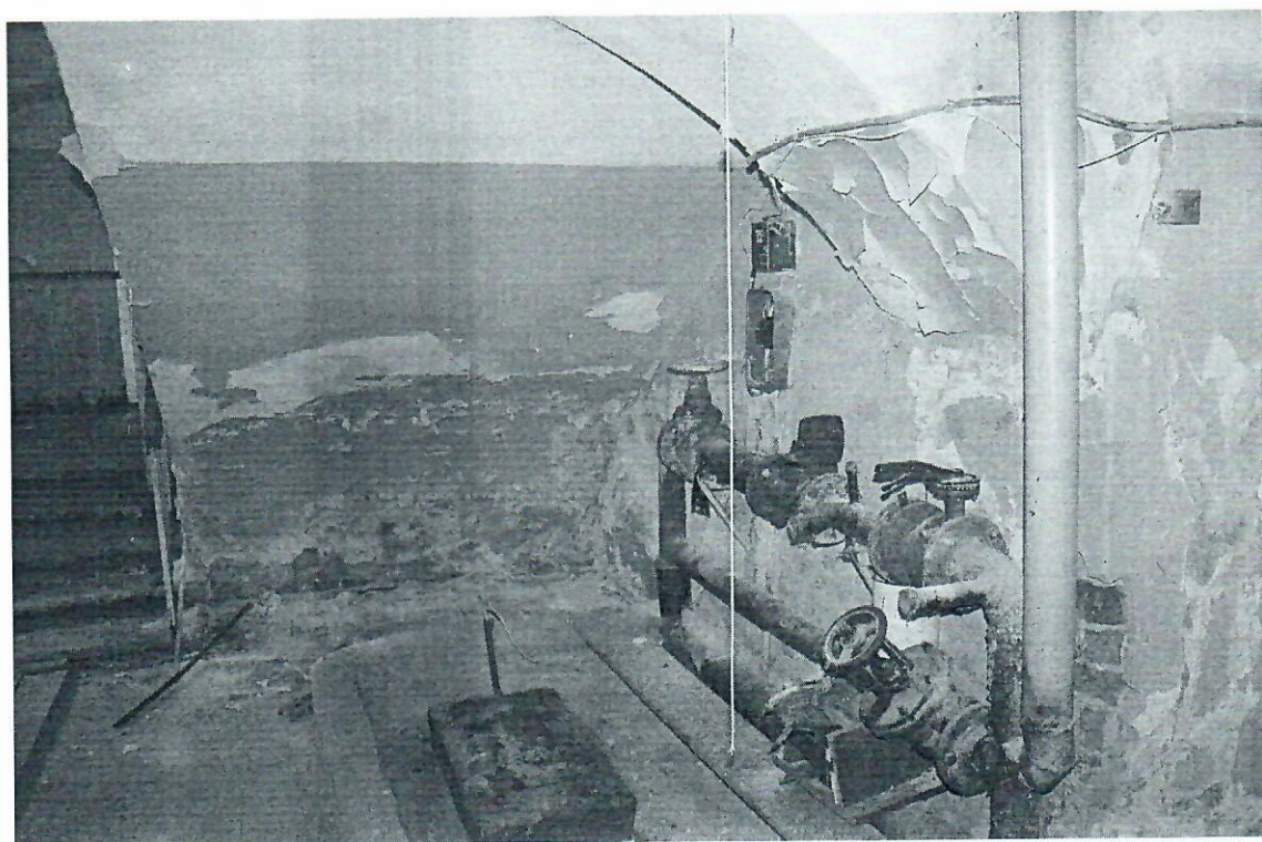
Фото 17. Помещение первого этажа.
