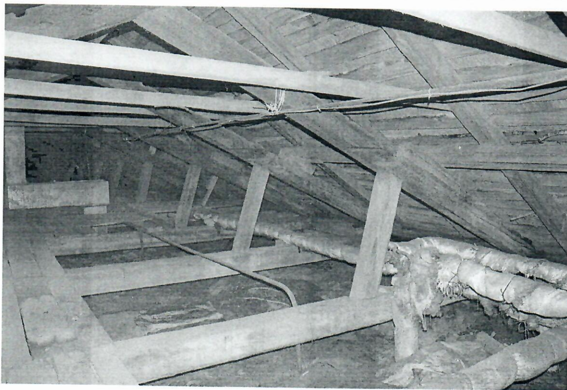
Фото 37. Состояние стропильных конструкций.
