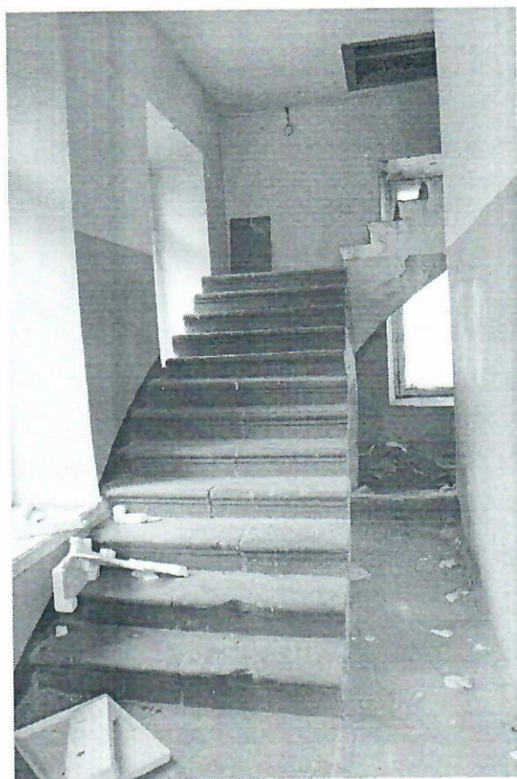
Фото 34. Лестница на чердак.
