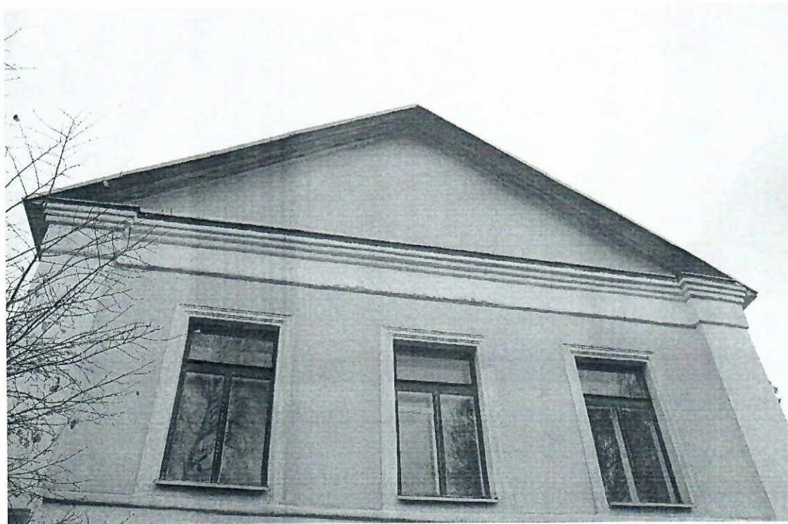
Фото 3. Фрагмент юго-западного фасада.
