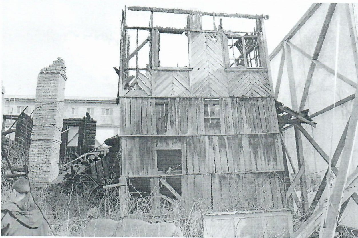
Фото 4. Стена южной пристройки.
