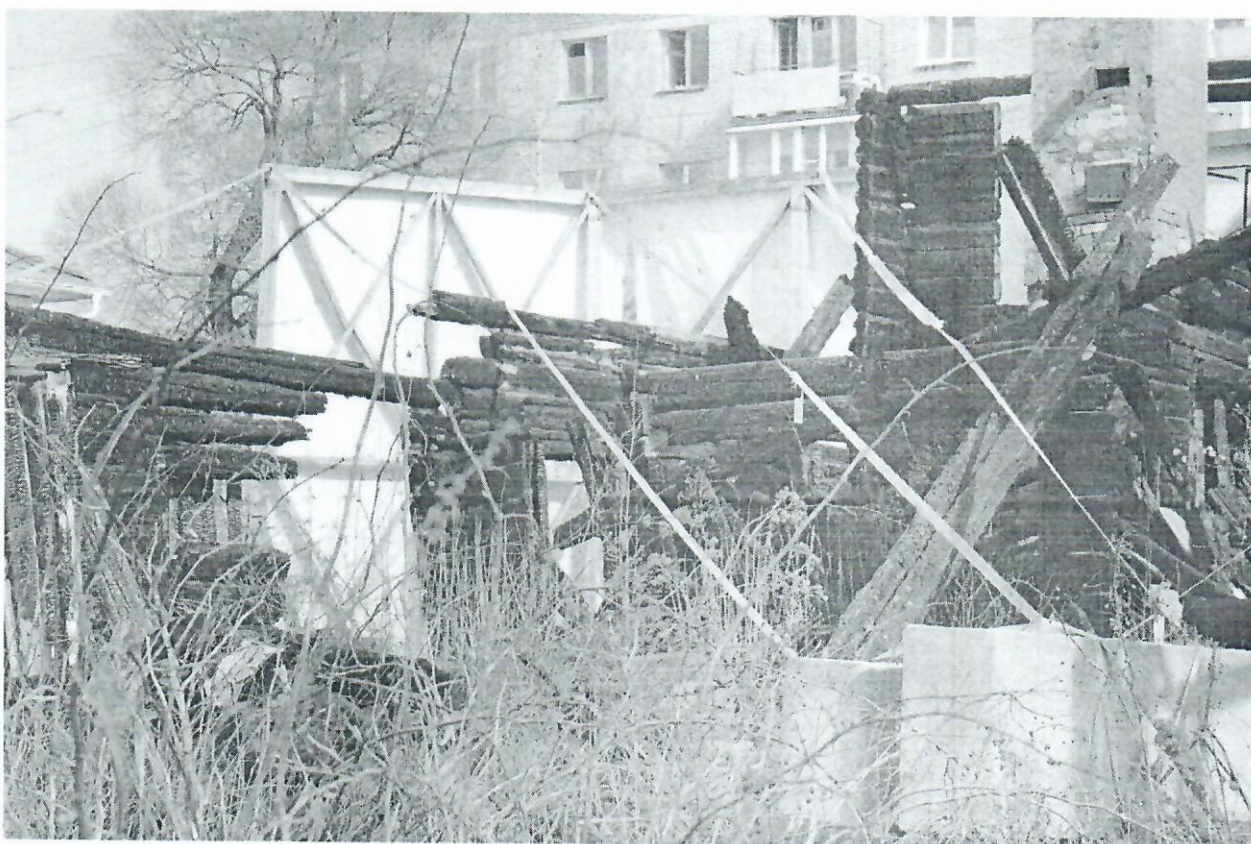
Фото 5. Руины объекта и каркас с креплением баннера.
