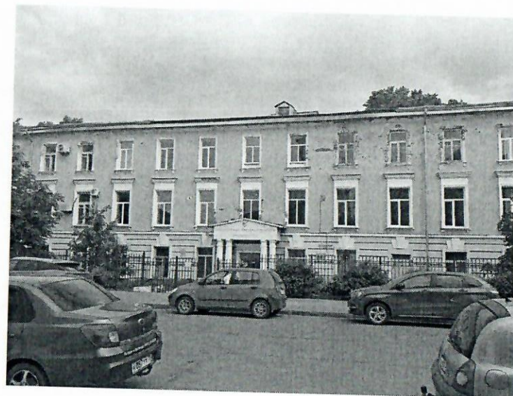
Фото 4. Фрагмент южного фасада. Блоки кондиционеров.
