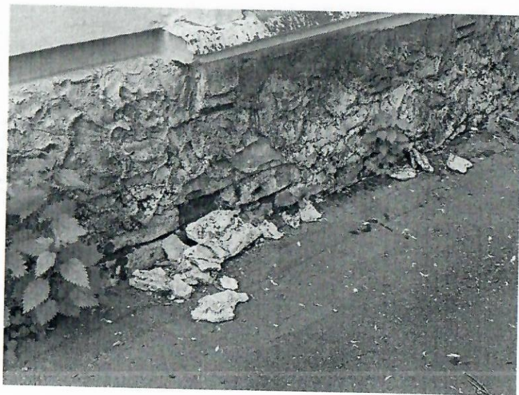
Фото 11. Состояние цокольной части.
