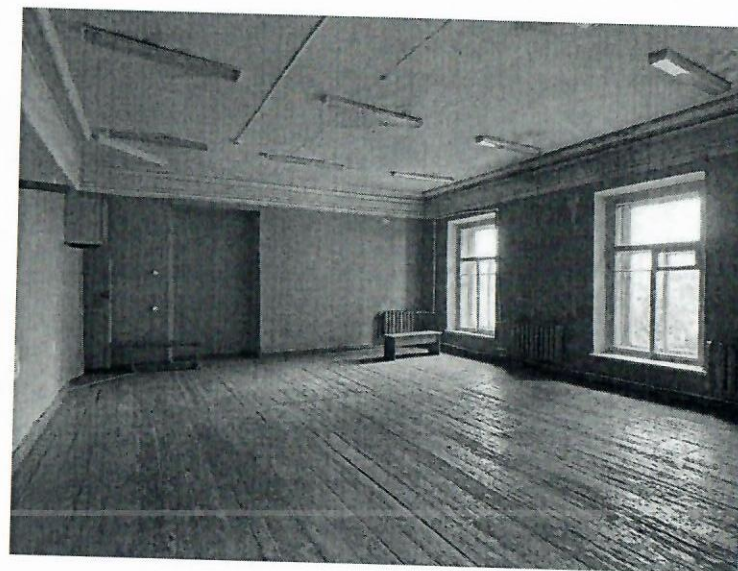
Фото 45. Помещение третьего этажа.
