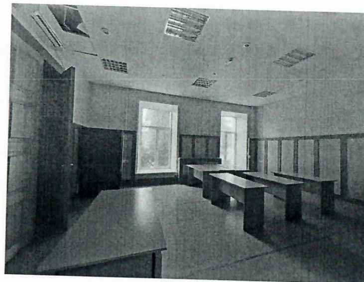
Фото 44. Помещение третьего этажа.
