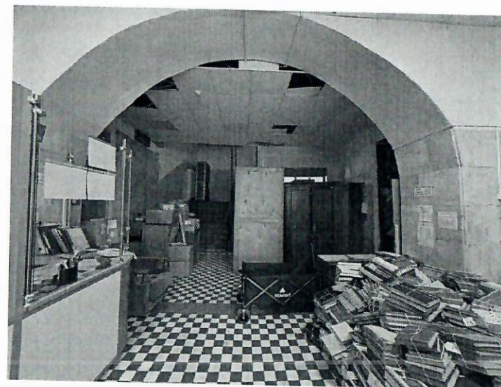
Фото 29. Помещение первого этажа.
