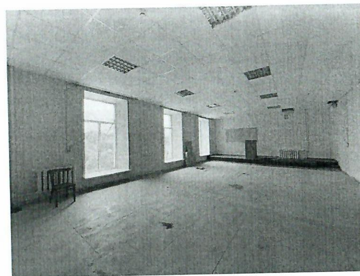
Фото 40. Помещение второго этажа.
