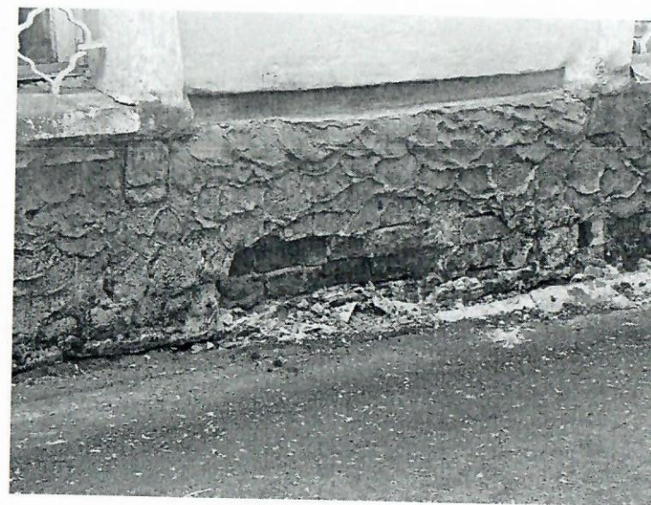
Фото 12. Состояние цокольной части.
