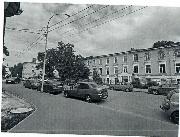
Фото 3. Фрагмент южного фасада.
