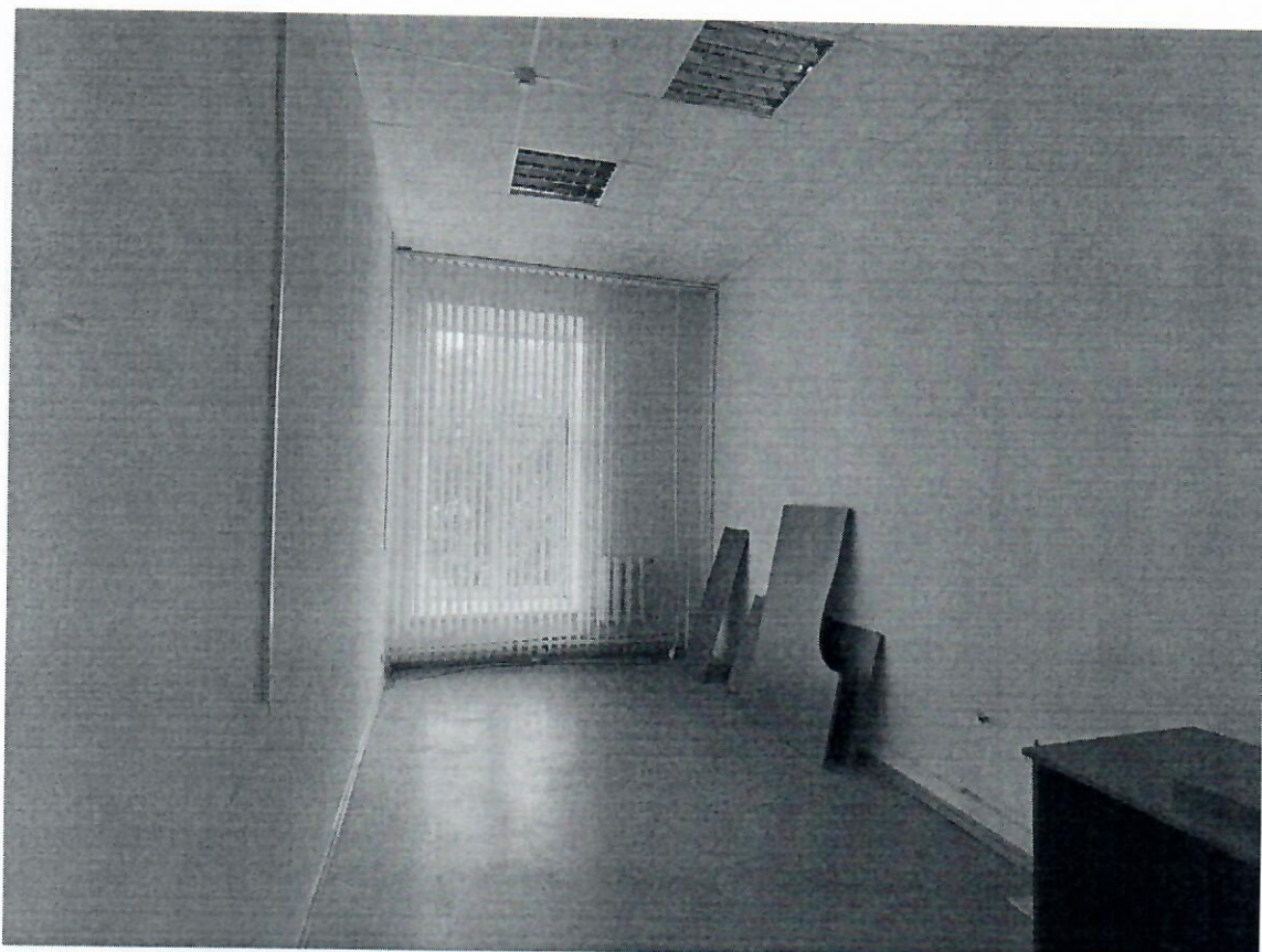
Фото 34. Помещение второго этажа.
