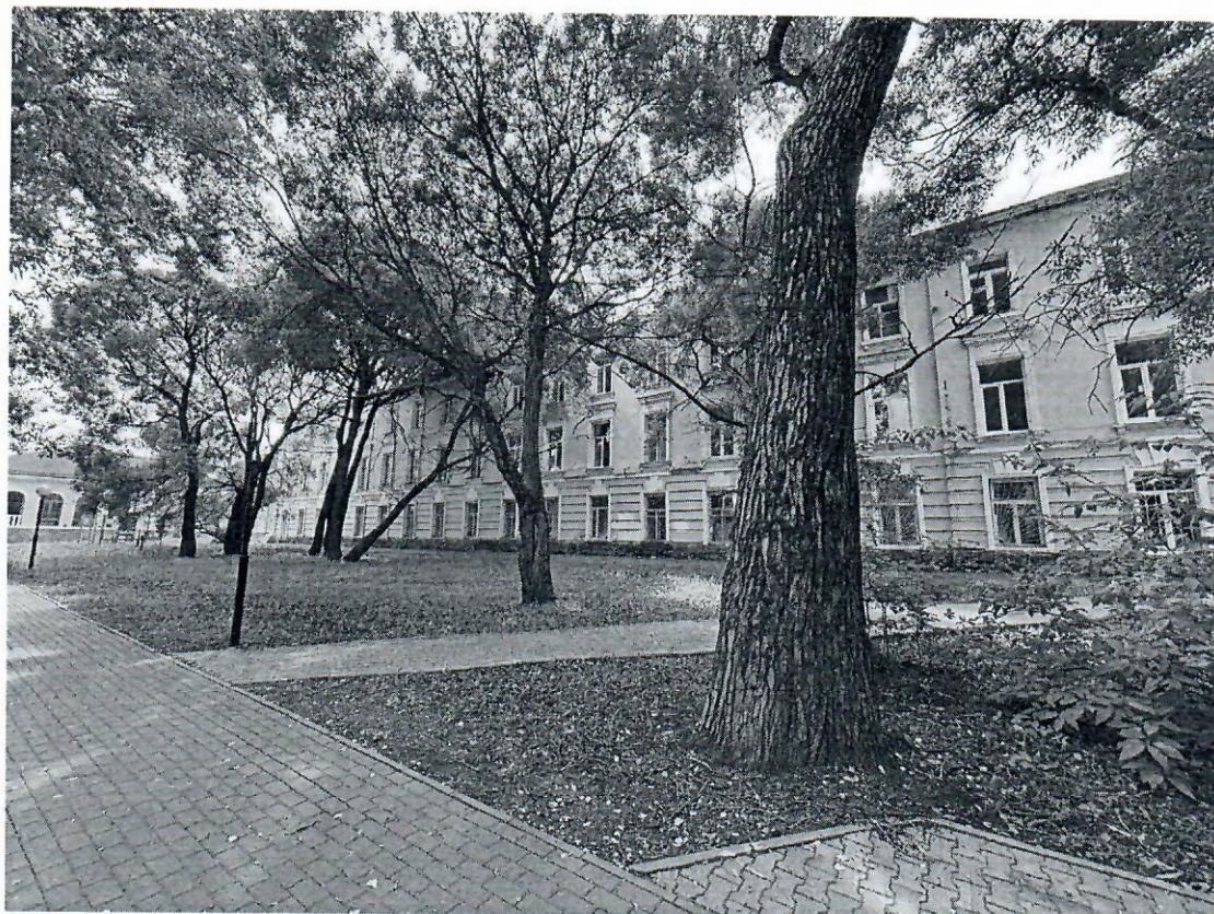
Фото 6. Фрагмент северного фасада.
