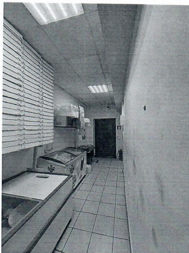
Фото 22. Помещение первого этажа.
