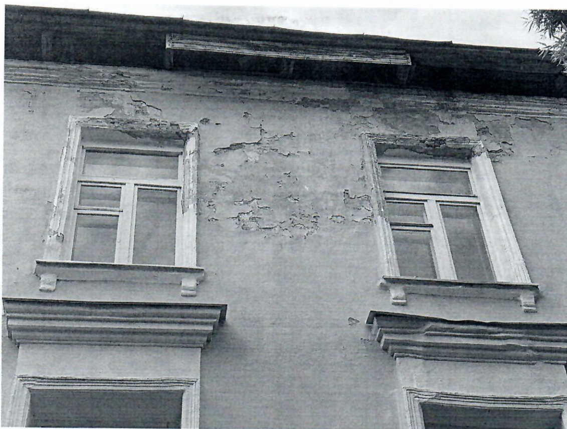
Фото 10. Состояние стен, окон и карниза.
