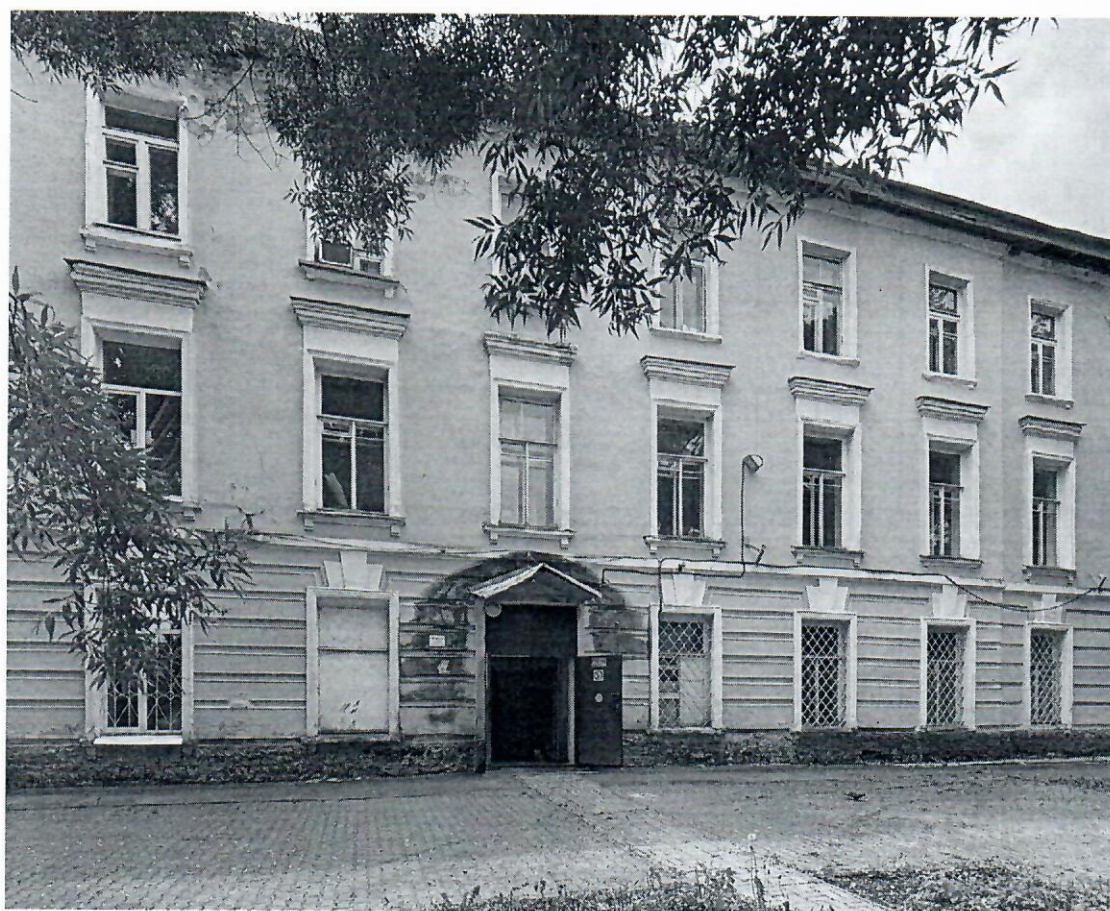
Фото 7. Фрагмент северного фасада.
