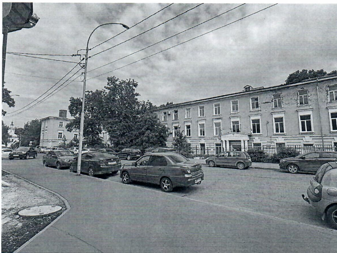
Фото 3. Фрагмент южного фасада.
