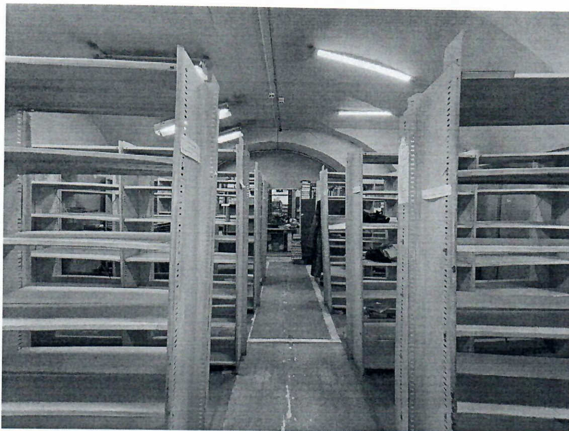
Фото 26. Помещение первого этажа.
