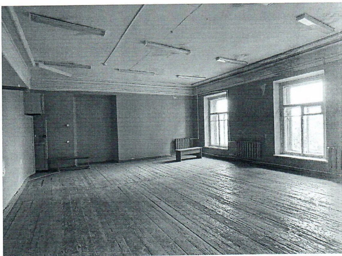
Фото 37. Помещение третьего этажа.
